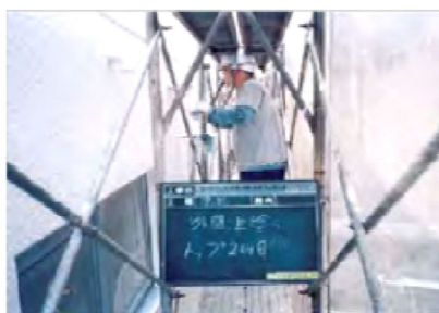
塗装・吹付け直しの例
