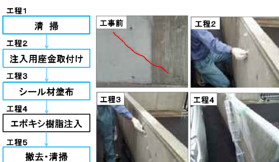
ひび割れの補修事例
