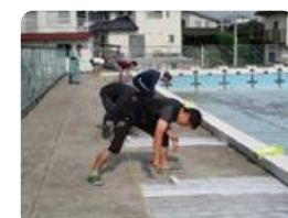
学校施設環境整備活動 支援事業による プールサイドの塗装
