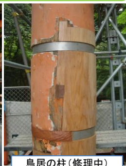
鳥居の柱(修理中)
