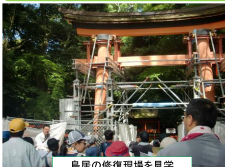
鳥居の修復現場を見学
