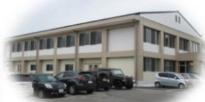
長洲小 体育館(H27.7月完成)
