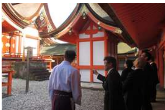
《国宝宇佐神宮本殿 保存修理現場視察》
