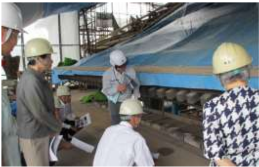
《修復現場視察（四日市別院）》
