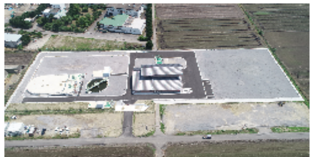
宇佐水再生プラザ(柳ヶ浦処理分区)
