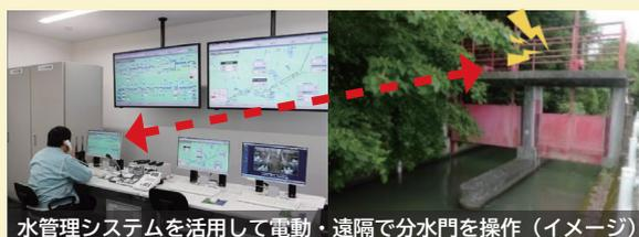
水管理システムを活用して電動・遠隔で分水門を操作（イメージ）
