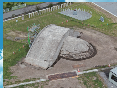
保存整備工事中的の掩体壕
