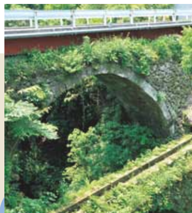
打上橋 Uchiagari Bridge 〈市指定有形文化財〉
