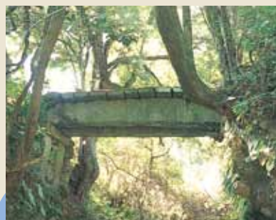
久地橋 Kyuchi Bridge 〈市指定有形文化財〉
