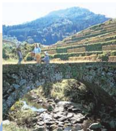
両合川橋 Ryoigawa Bridge 〈国登録有形文化財〉
