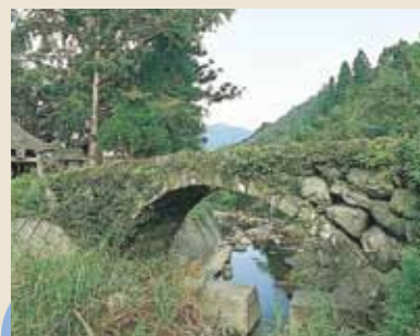
一の橋 Ichino Bridge 〈市指定有形文化財〉
