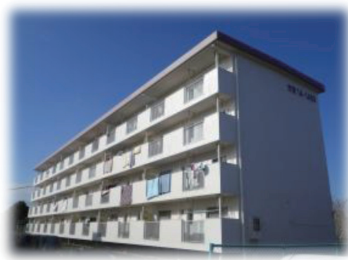
(外壁改修工事を行った団地風景)
