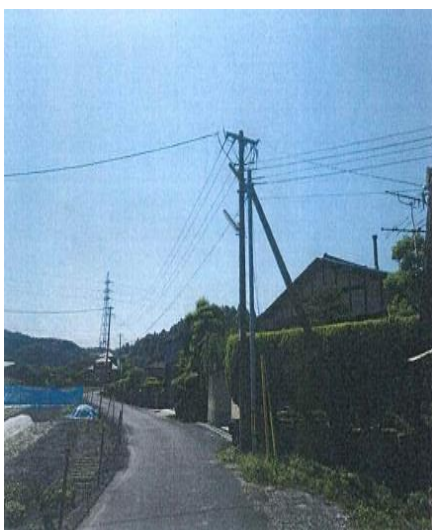
① 遠景写真（柱全体・道路）
