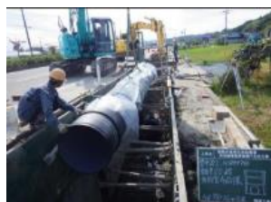
既設水路のパイプライン化
