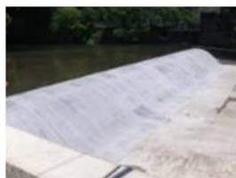
頭首工の補修
