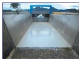
幹線用水路の補修
