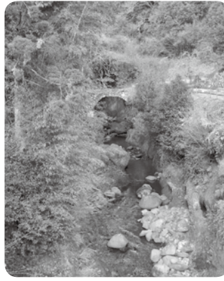
橋詰水路橋と高並川
