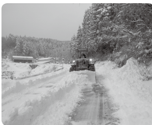
院内町県道下恵良九重線の「除雪作業」
