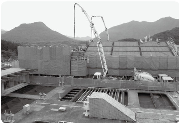
改修が進む山本浄水場
