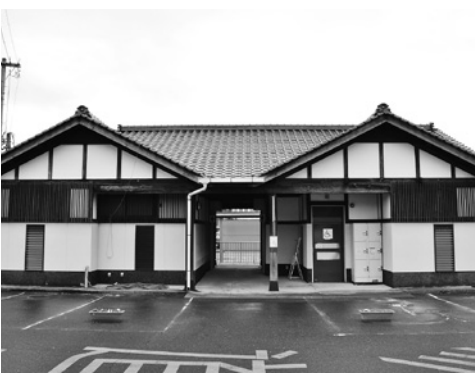
八幡駐車場トイレ
