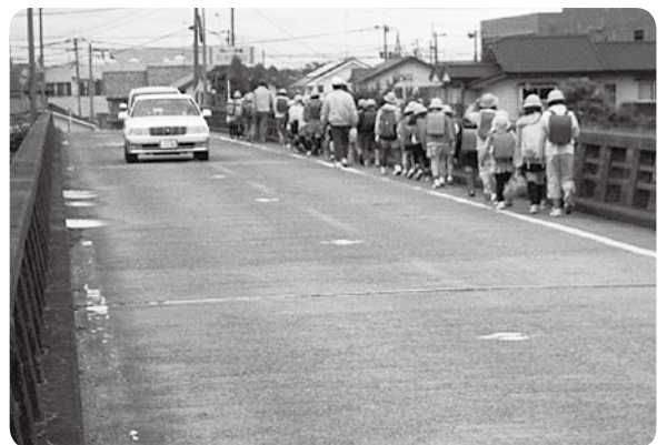
架け替えの進まない上田橋
