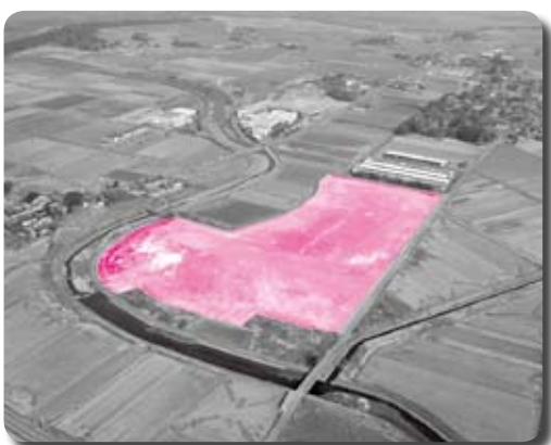
上空から見た「尾永井工業団地」
