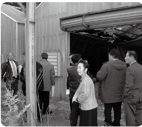
譲渡する農業用施設を調査(下高)
