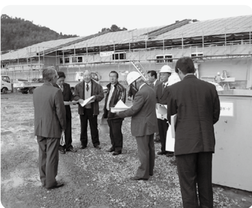
建設中の「南部学校給食センター」の調査
