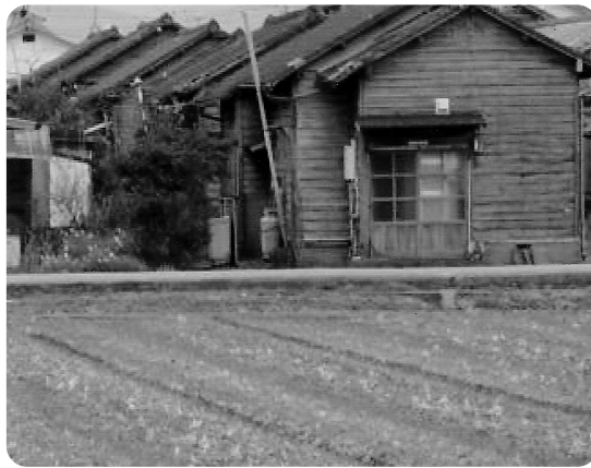
＝ 老朽化した市営住宅 ＝
