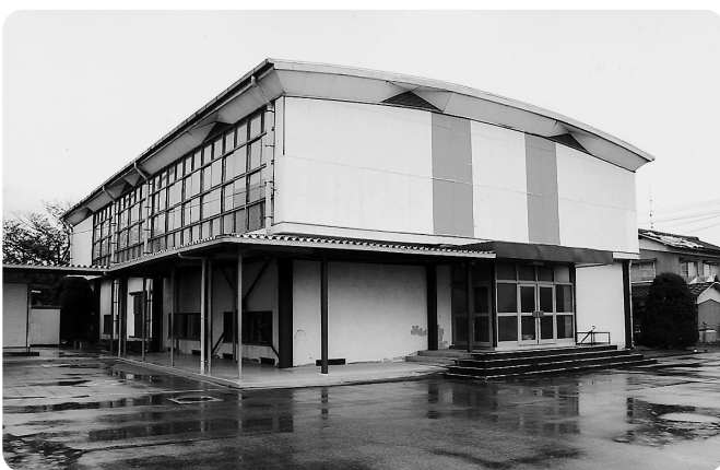
＝ 駅館小学校体育館 ＝
