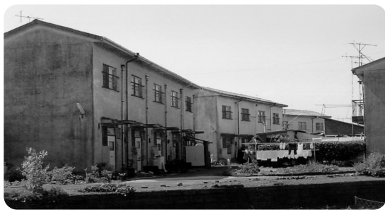
＝ 老朽化した住宅 ＝
