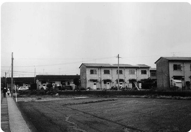
＝ 老朽化した市営住宅 ＝
