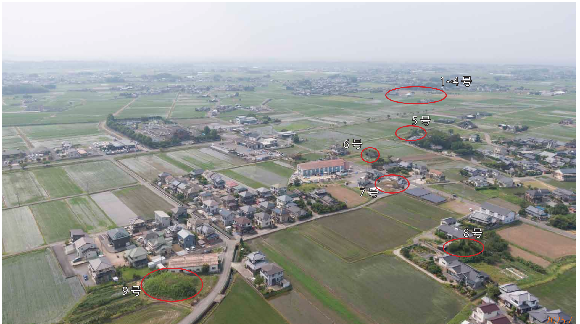
畑田・上田地区南東上空から撮影 5基の小型有蓋掩体壕が現存しています。
