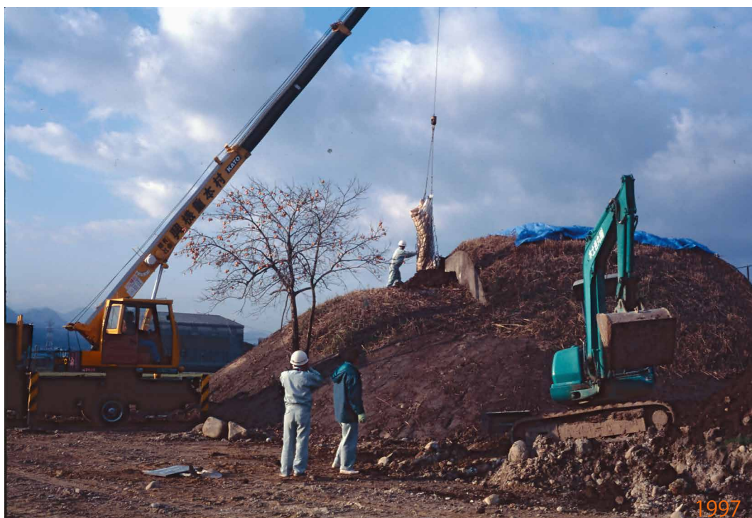
平成 9 年盛土復元状況
