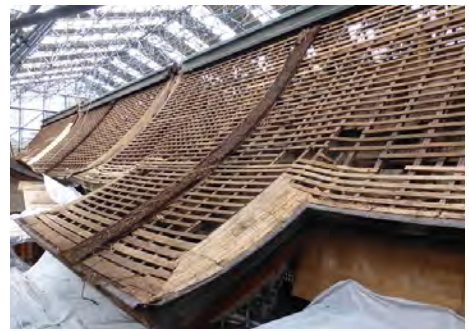
国宝 宇佐神宮本殿の修復工事
