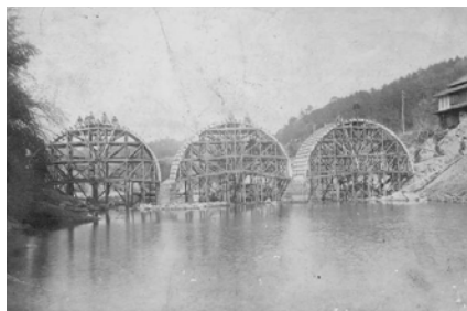
分寺橋架橋時の支保工 (昭和 20 年)
