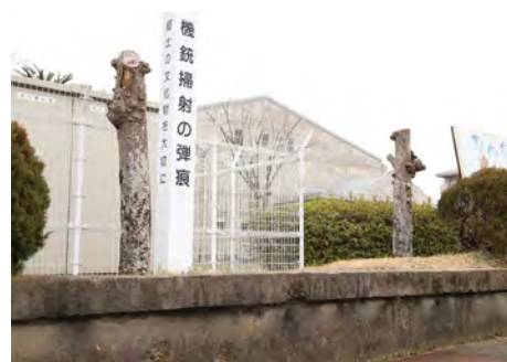
市登録有文 旧三洲国民学校コンクリート塀
