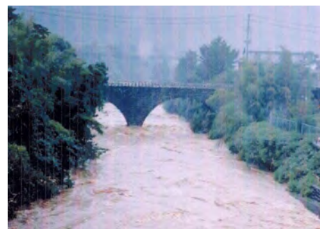
平成 5 年の豪雨時 荒瀬橋付近
