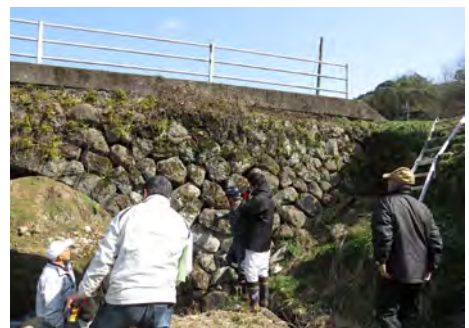
石橋の定期点検
