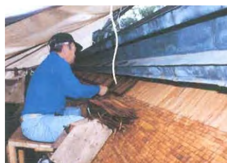
県選定 屋根桧皮づくり及び屋根桧皮葺きの技術
