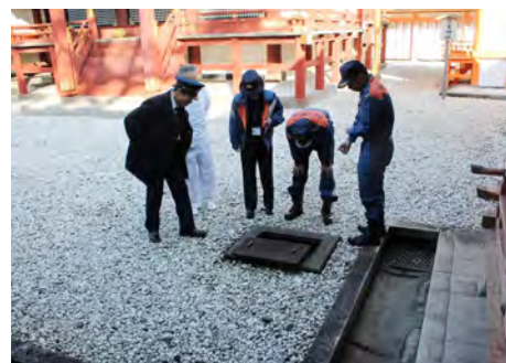
文化財防火デー 消防設備の点検
