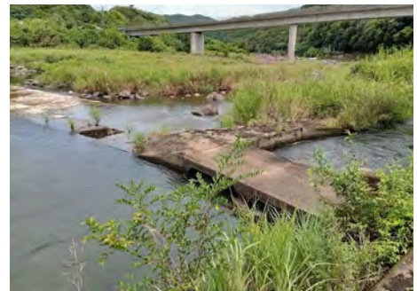
広瀬井路取水口
