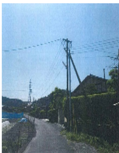
② 遠景写真（道路・柱全体）
