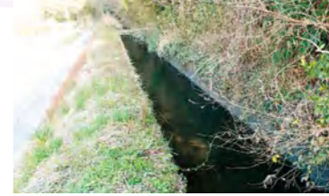
幹線水路 宇佐市長洲まで総延長17キロ高低差約40メートル
