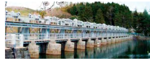
安積疎水十六橋水門(提供：安積疎水土地改良区)
