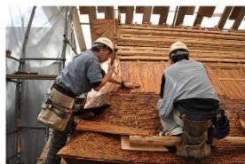
建造物の修理
