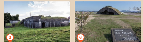
3 半地下式コンクリート造建物
