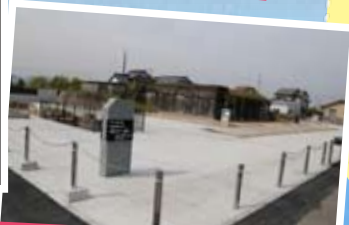
耐弾式コンクリート造建物
